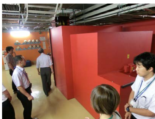
放射線遮蔽の重厚な扉で仕切られてい
